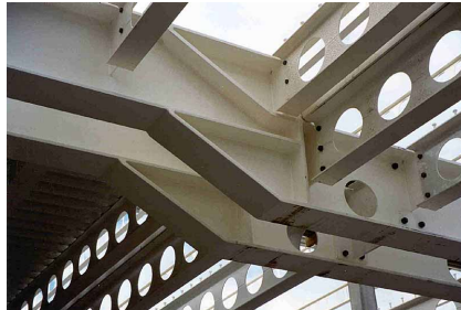
Détail de décaissement
