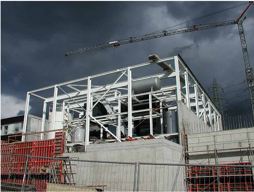
Montage de la structure
