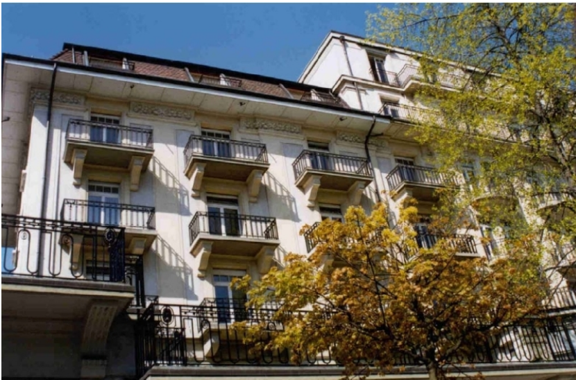
Vue de la façade sud
