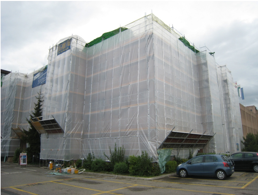
Rénovation en cours
