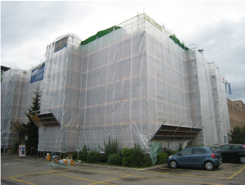
Rénovation en cours
