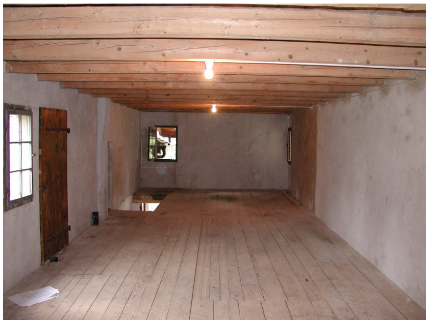
Plancher bois existant
