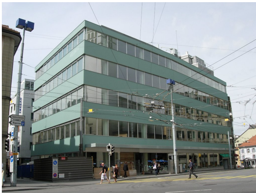
Façade du bâtiment rénové
