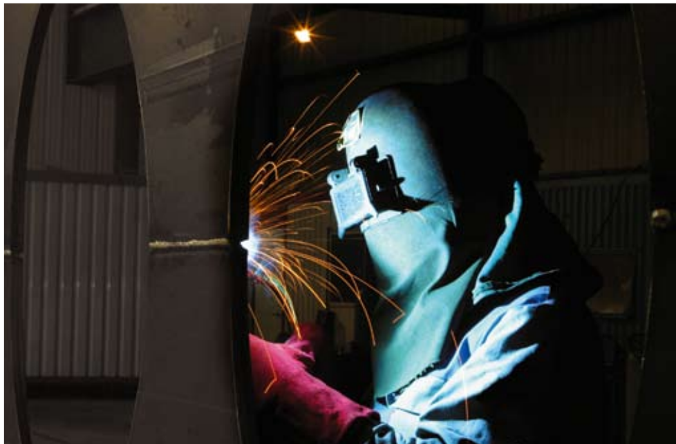
Fabrication des poutres ACB®
