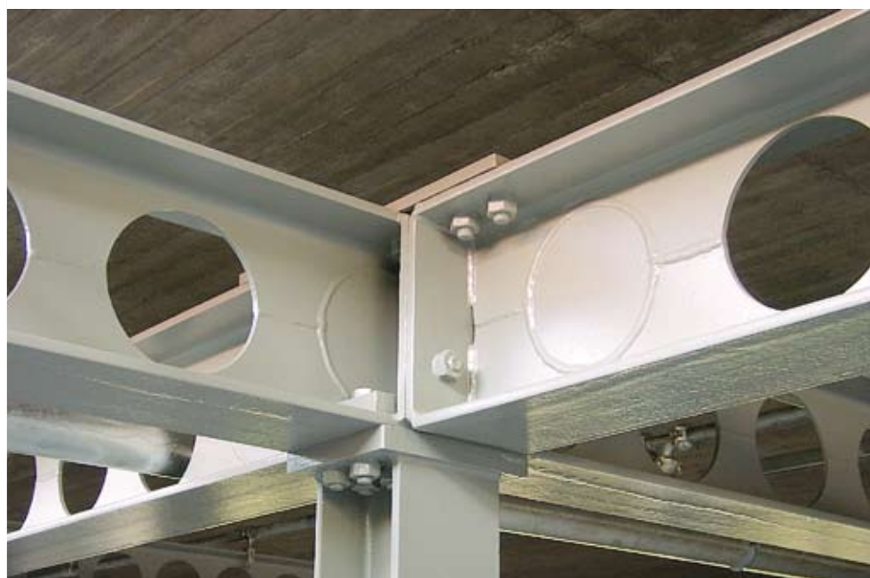
Figure 11b : Exemple de poutre ACB® avec alvéole renforcée
