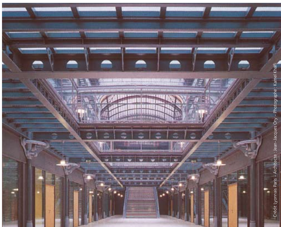
Figure 2 : Rénovation à l'aide de poutrelles cellulaires ACB®
