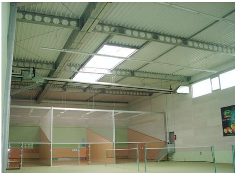
Figure 1 : Poutre ACB® de couverture
