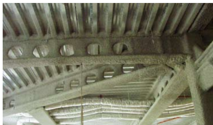
Figure 31 : Protection par flocage d'une poutrelle ACB®
